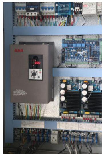
底盘测功机控制系统为带反馈的闭环控制系统。系统采集车速信号与扭力信号, 根据不同检测项目采样不同的控制模型, 常用的控制模型有恒速控制、恒扭控制、恒功率控制。
